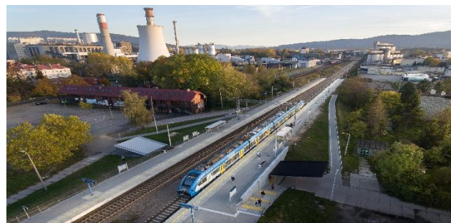
Przebudowa linii kolejowej nr 139 Intop Warszawa Sp. z o.o.
