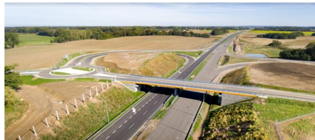
Droga ekspresowa S6 Strabag Sp. z o.o.
